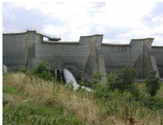
Le barrage du Verdon
