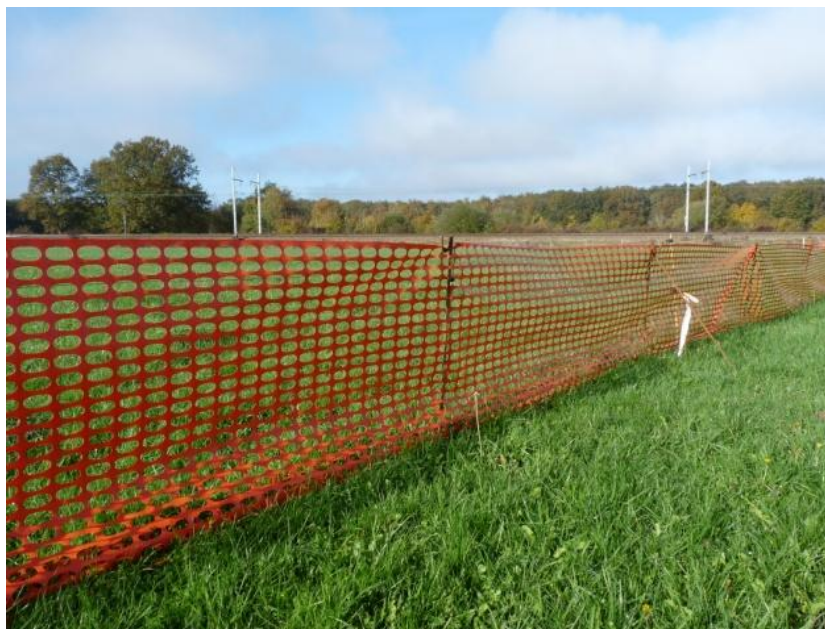
Figure 37 - Illustration d'exemples de balisages de chantier
