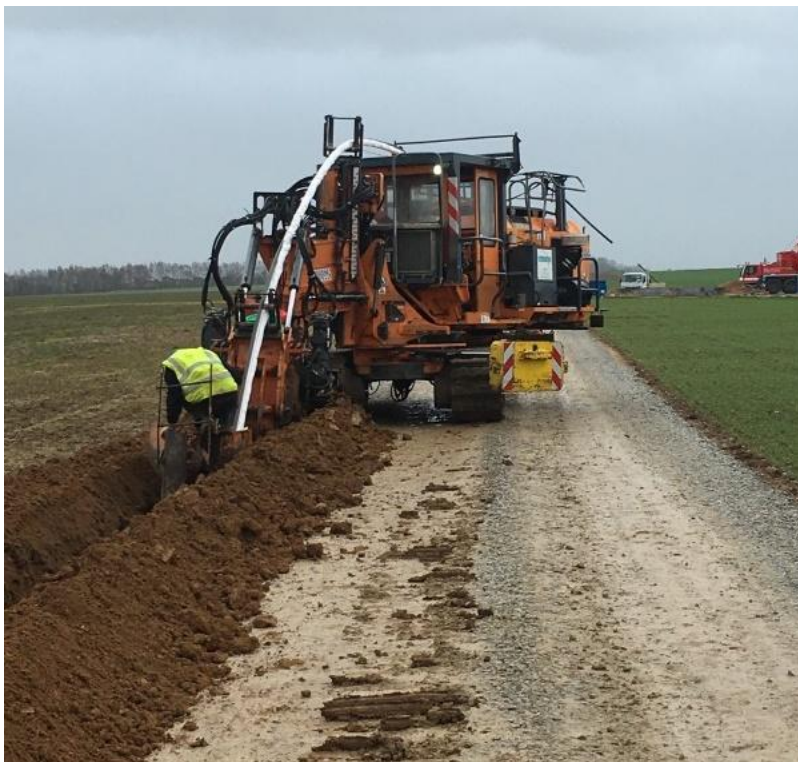
Figure 88 : Mise en place d'une liaison souterraine HTA (source : elec-enr.com)
