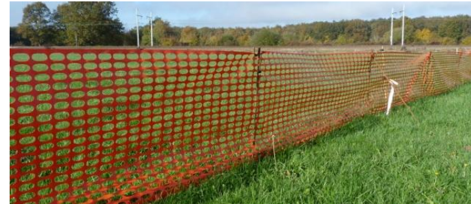
Figure 134 : Illustration d'exemples de balisages de chantier
