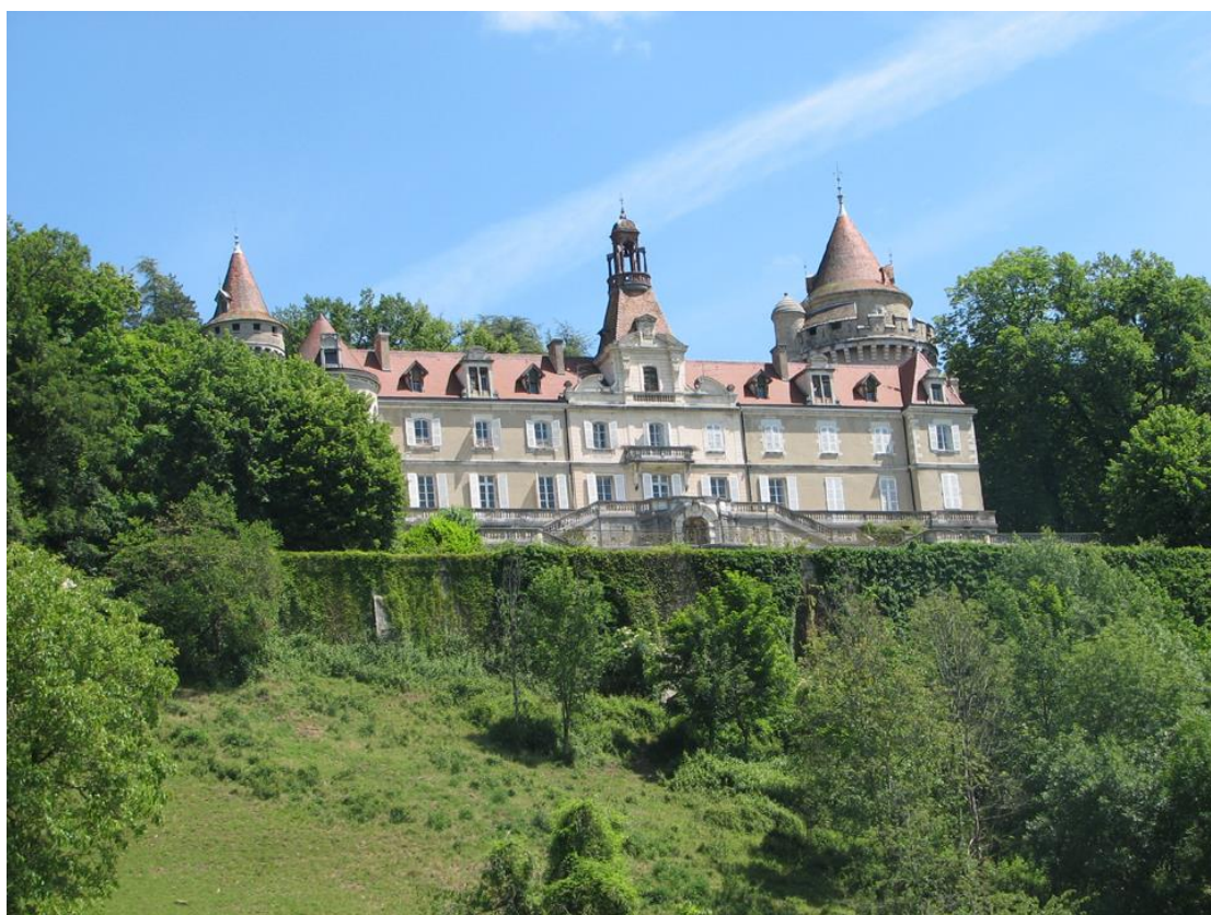
La façade sud, son escalier desservant les terrasses ©ESciardet-UDAP01
