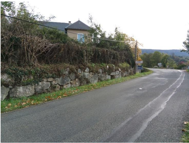
Abords immédiats - Secteur bâti au carrefour entre le hameau et la route menant à Champagne-en-Valromey
