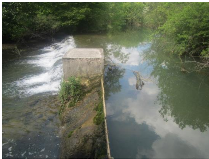
Au premier plan la rive gauche et la partie du seuil en planche de bois plus haute que la crête béton de la rive gauche. (TEREO)
