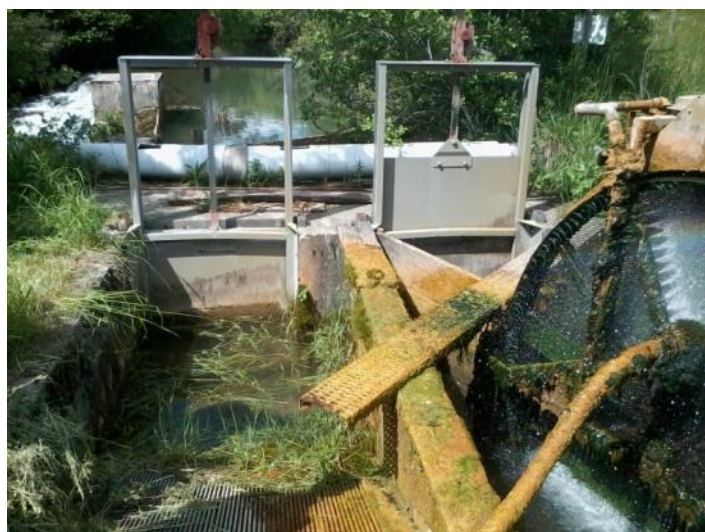
Vannes et défeuilleur au niveau de la prise d'eau du bief d'amenée à la pisciculture (HYDROTOPO)
