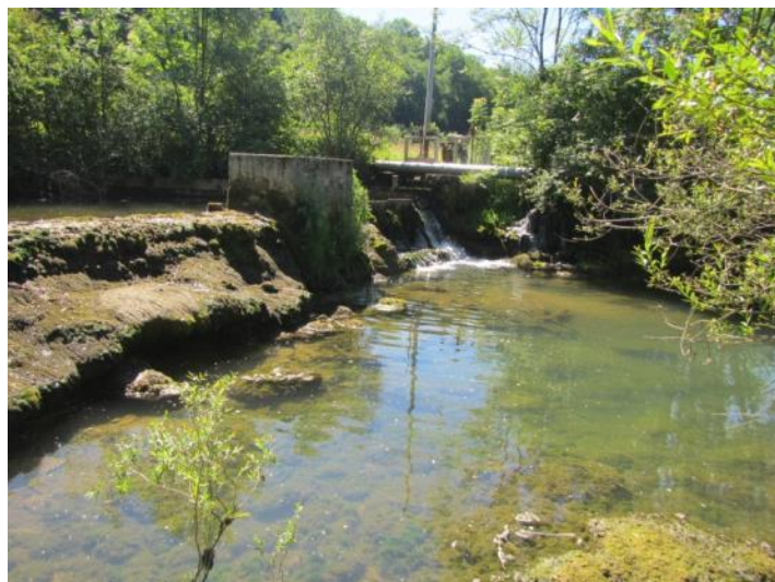
Vue sur la rive gauche depuis l'aval. En étiage, les débits s'écoulent par l'échancrure dans les planches bois (TEREO)
