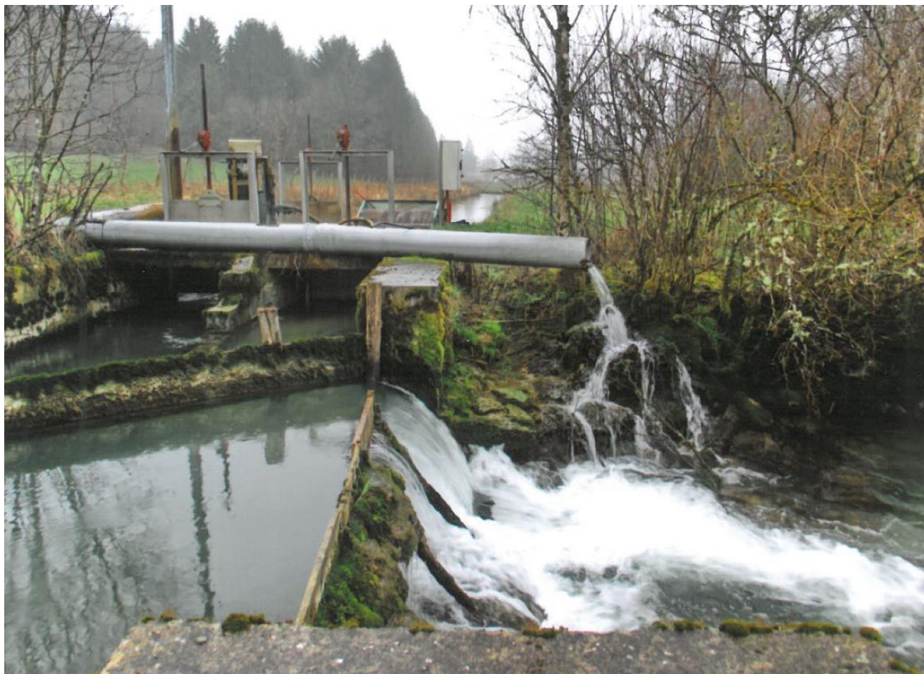
Photographie 1: Vue de la rive gauche du seuil du Valouson et de la prise d'eau de la pisciculture
