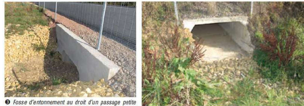
③ Fosse d'entonnement au droit d'un passage petite faune d'une section d'infrastructure située au niveau du terrain naturel. RD 16 (CD57). Source : Cerema.
