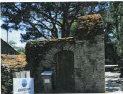
8 - Vestige de bâti ancien, route de la Frodouillère
