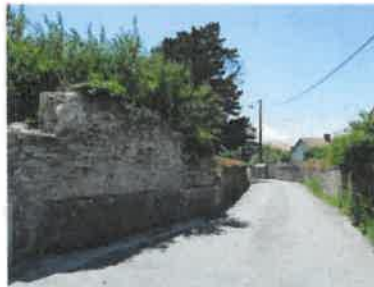
2 - Chemin des jardins - Murs maçonnés anciens
