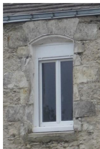
Exemple d'encadrement de baie avant enduit (façade arrière)
