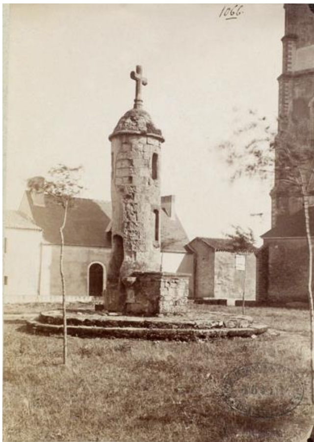
Lanterne avant restauration (1886)
