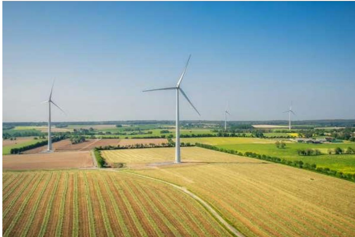
SENONNES & CONGRIER Bretagne, Frankreich, 2023 EnerconTyp E-103Nabenhöhe 105m 4 Anlagen9,4 MW
