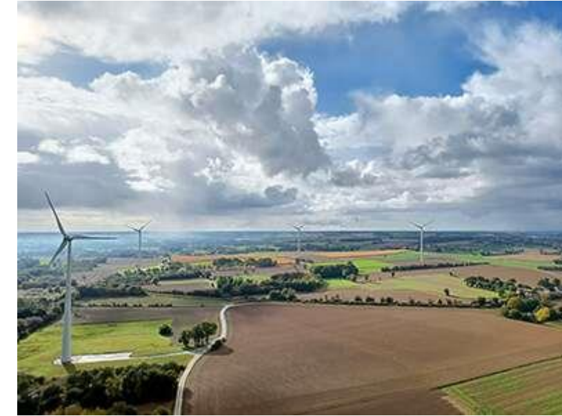
BROONS & YVIGNAC-LA-TOUR Bretagne, Frankreich, 2021 EnerconTyp E-92Nabenhöhe max. 104m 6 Anlagen14,1 MW
