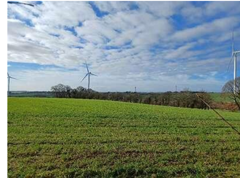
TRÉVÉ - LOUDÉAC Bretagne, Frankreich, 2023 NordexTyp N117Nabenhöhe max. 120m 6 Anlagen18 MW
