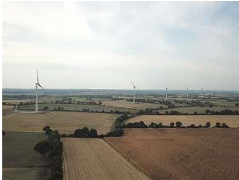
LA CHAPELLE GLAIN Pays de la Loire , Frankreich, 2020 EnerconTyp E-92Nabenhöhe 85m 5 Anlagen11,75 MW
