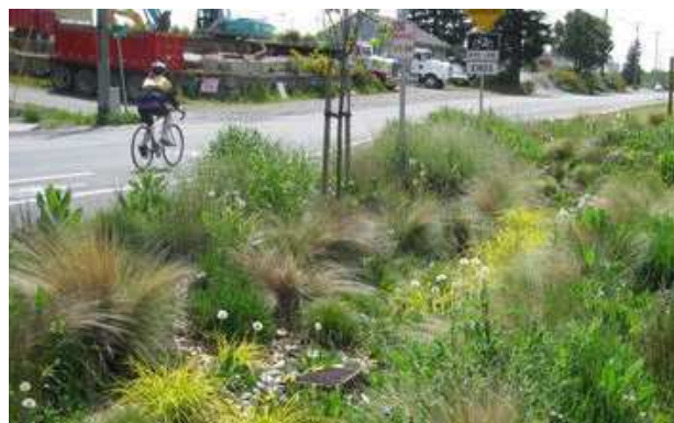
La noue végétalisée contribue à gérer les eaux pluviales et à améliorer le paysage urbain
