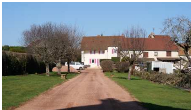
Exemple d'allée avec un revêtement perméable
