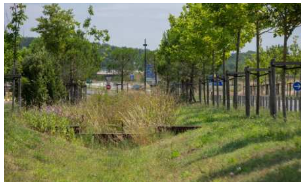
Exemple de noue paysagère en bordure de voie.
