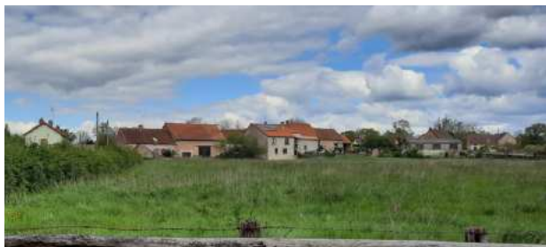
① Vue sur le site vers le Nord, avec derrière le front bâti, la présence de la départementale RD17
