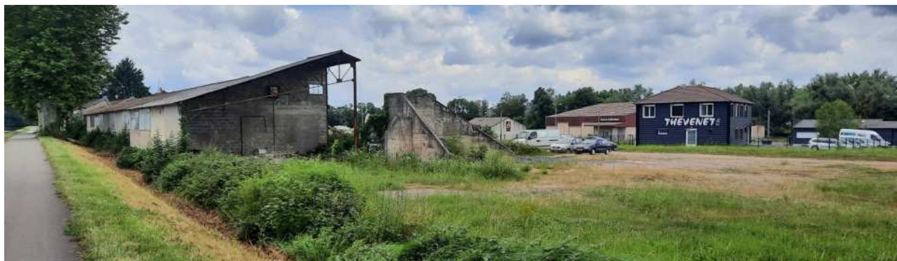
1 Vue depuis la Petite Levée du Canal sur le tènement
