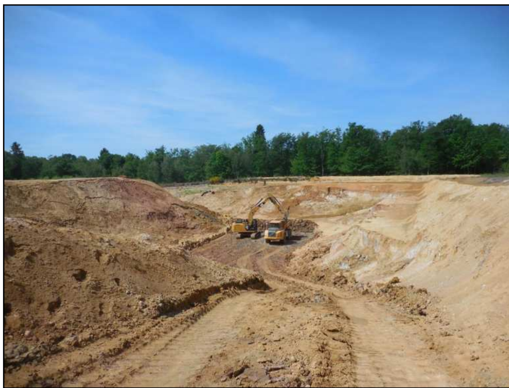
Photographie 1 : Extraction des matériaux
