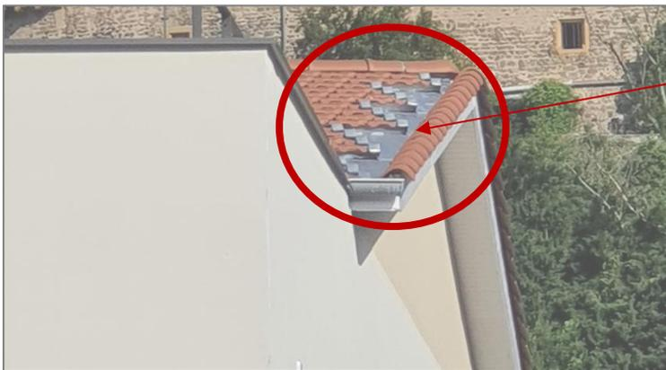
Type de « finition » de toiture interdite »
