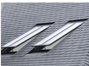
Châssis intégrés dans la pente
