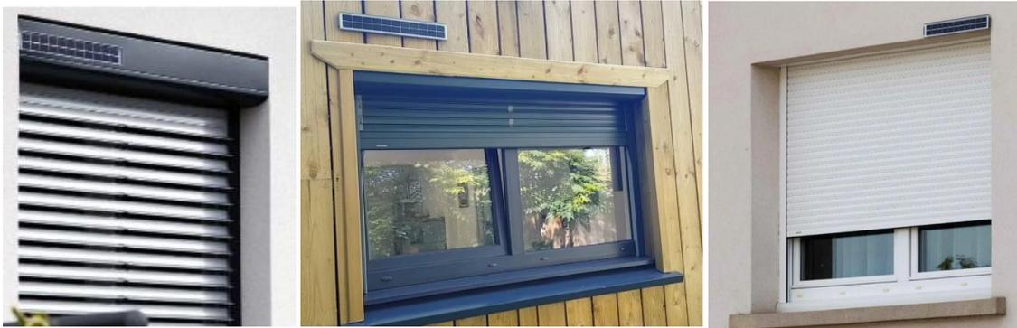
Illustration de type d'insertion non saillante des volets roulants à mettre en œuvre
