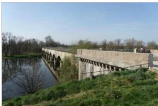
Pont-canal de Digoïn
