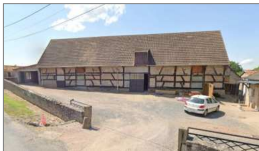
Ancien bâtiment agricole à colombages (souvent retrouvé dans la vallée de la Loire) au lieudit Le Péage à Molinet.
