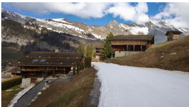
Etat des lieux avant travaux.
