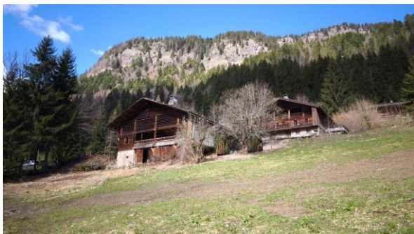
Etat des lieux avant travaux.
