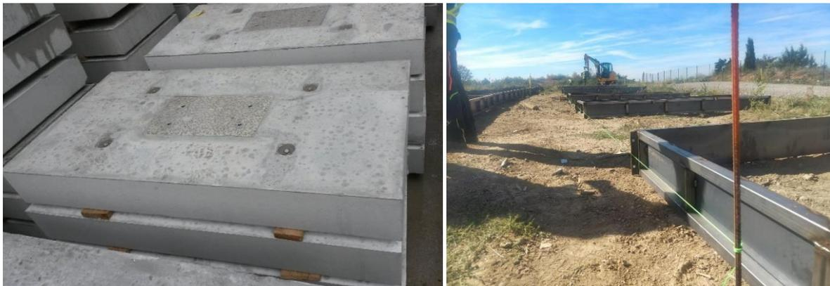
Figure 34 : Exemple de fondation fabriquée en série en usine (gauche) et fondation coulée en place (droite)
