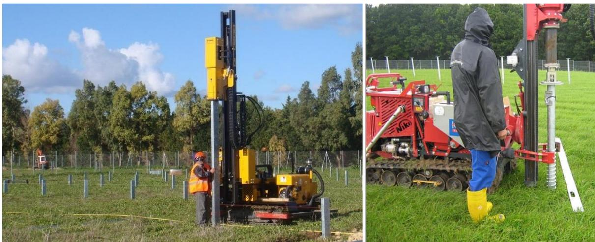
Figure 32 : Sonnette de battage hydraulique(gauche) et machine hydraulique de vissage (droite)
