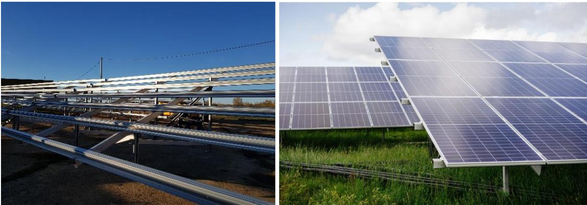
Figure 29 : Illustrations de table fixe sans modules (gauche) et table fixe 3VH (3 modules verticaux) (droite)
