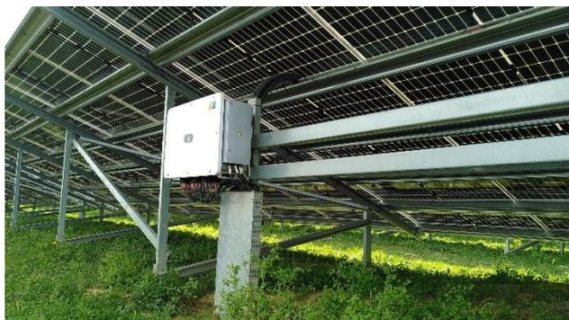
Figure 35 : Exemple d'onduleur accroché derrière les tables de modules
