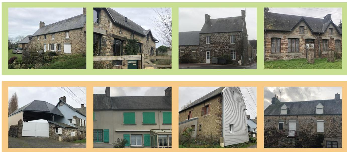
Figure 76 : exemples de restaurations et conservations réussies dans l'encadré vert ; contre-exemples et points de vigilance sur les pierres recouvertes, les couleurs saturées, l'isolation par l'extérieur et les volets roulants dans l'encadré orange
