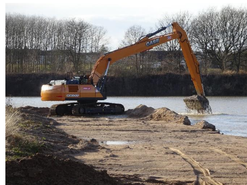
Pelle à bras long utilisée pour l'extraction des matériaux (ENCEM)
