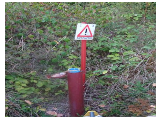
Piezomètres appartenant au réseau de surveillance des eaux souterraines (ENCEM)
