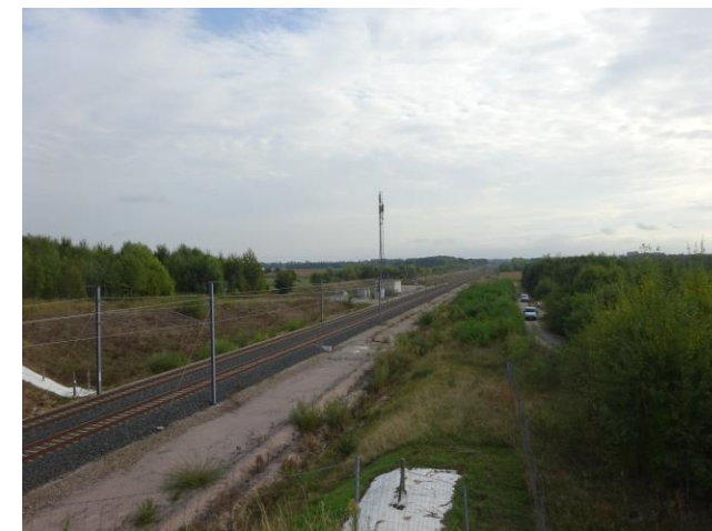
Ligne LGV au Nord du projet (ENCEM)
