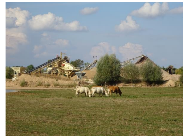
Vue de l'installation de traitement depuis la berge Est de l'actuel plan d'eau d'extraction (ENCEM)
