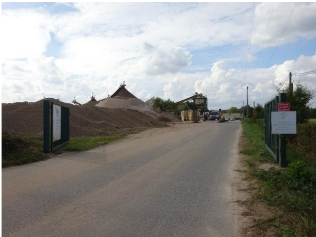
Figure 4 : Voie d'accès au site et portail d'entrée (ENCEM)
