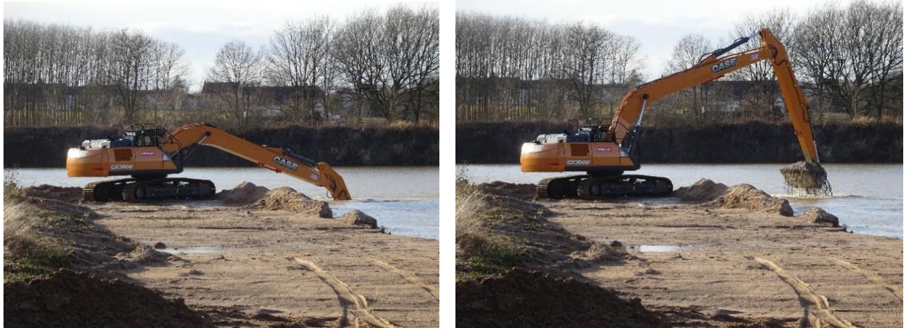
Figure 8 : Pelle à bras long utilisée pour l'extraction des matériaux (ENCEM)
