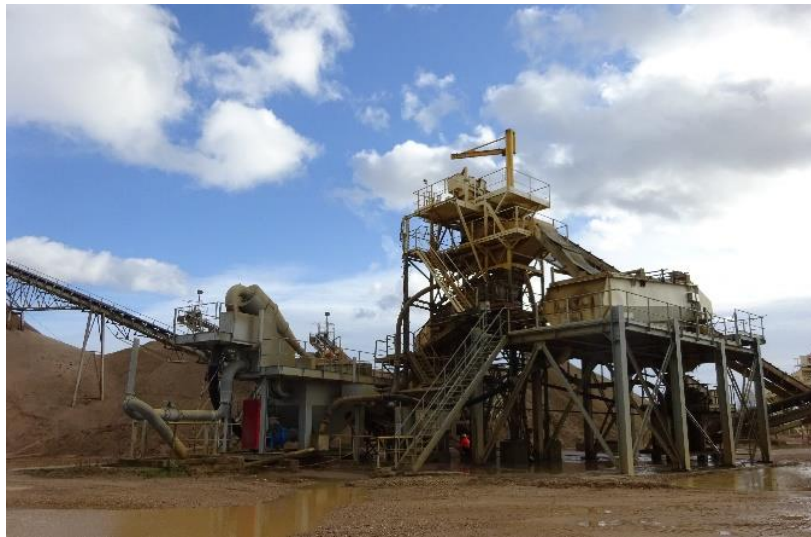
Figure 14 : Crible sous eau (ENCEM)
