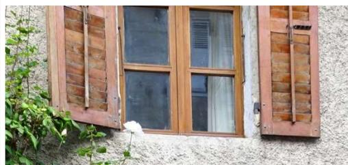
Exemple de volets anciens que l'on trouve à Chanaz. Un mécanisme permet d'actionner l'orientation des persiennes.
