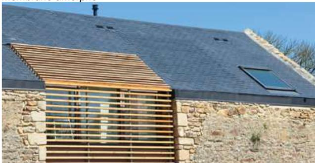
*panneau solaire thermique Thermoslate invisible (sous tuiles)*
