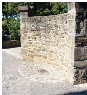
Exemple: pavés jointoyés au sable (sol perméable) et stabilisé (Chabریان, Drôme)
