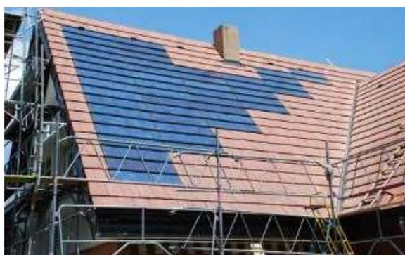
*Non respect des ouvertures et des lignes de la toiture ce qui crée un « trou »*
