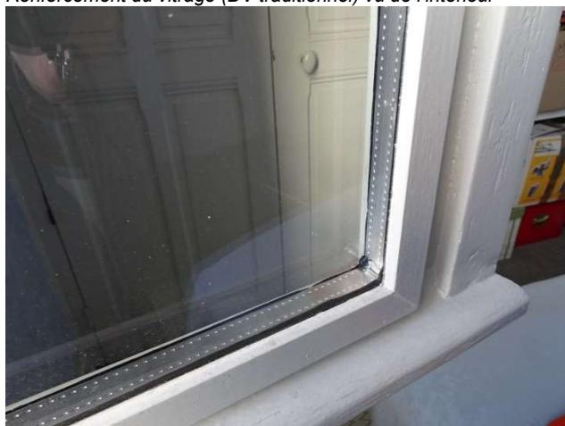
Renforcement du vitrage (DV traditionnel) vu de l'extérieur
