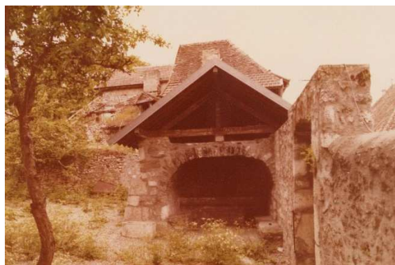
Four à pain dans la maison
