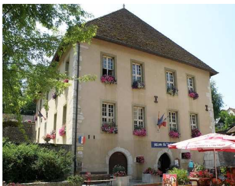
Façade principale de la maison
