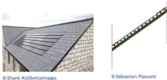
Figure 1 : Photovoltaïques et insertion sur l'habitat.
