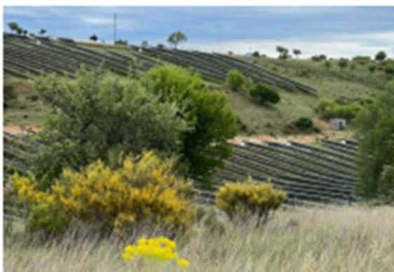
Figure 7 : Respect de la topographie : les panneaux ne sont pas installés sur les terrains en forte pente, aménageant ainsi un retrait des panneaux de part et d'autre de la cassure de la pente.
