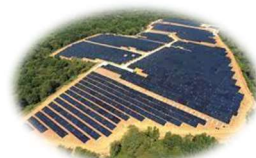
1 parc photovoltaïque au sol de 4ha au Temple
