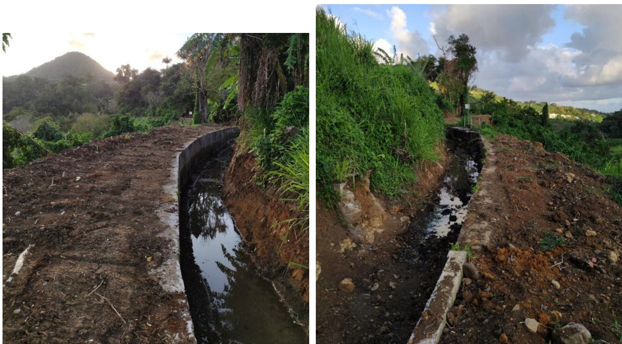
*Figure 13 : Canal d'amenée après le précédent débroussaillage en 2022*
