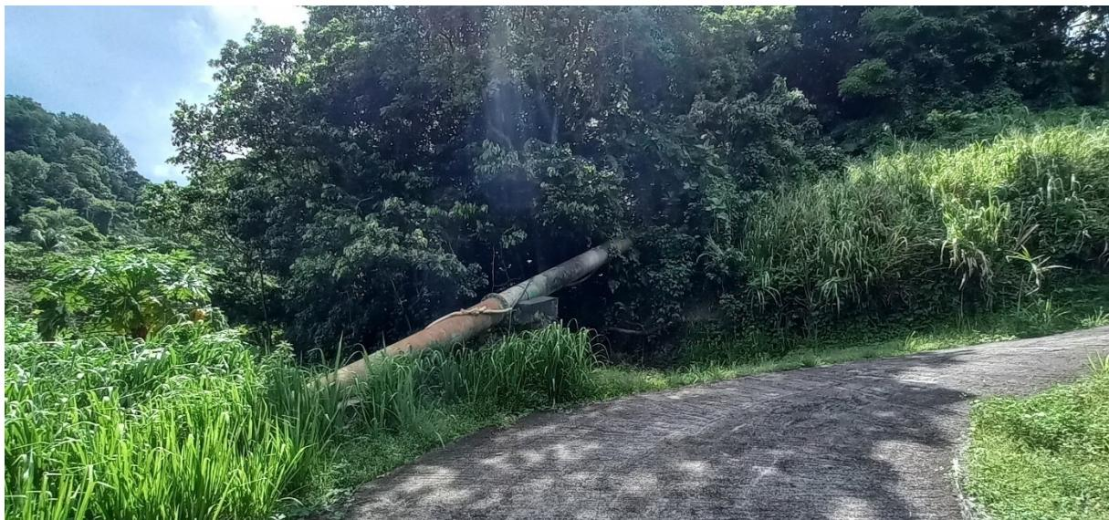
Figure 15 : Conduite forcée acheminant l'eau sous pression jusqu'à la turbine
