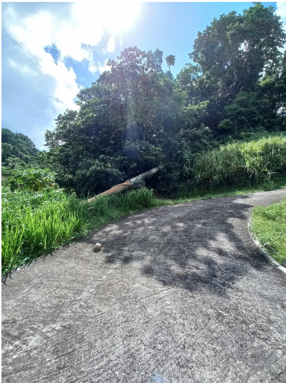
Figure 9 : Conduite forcée acheminant l'eau sous pression jusqu'à la turbine
