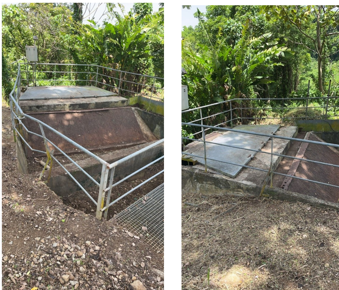
Figure 8 : Le bassin, la grille et la chambre de mise en charge à rénover
