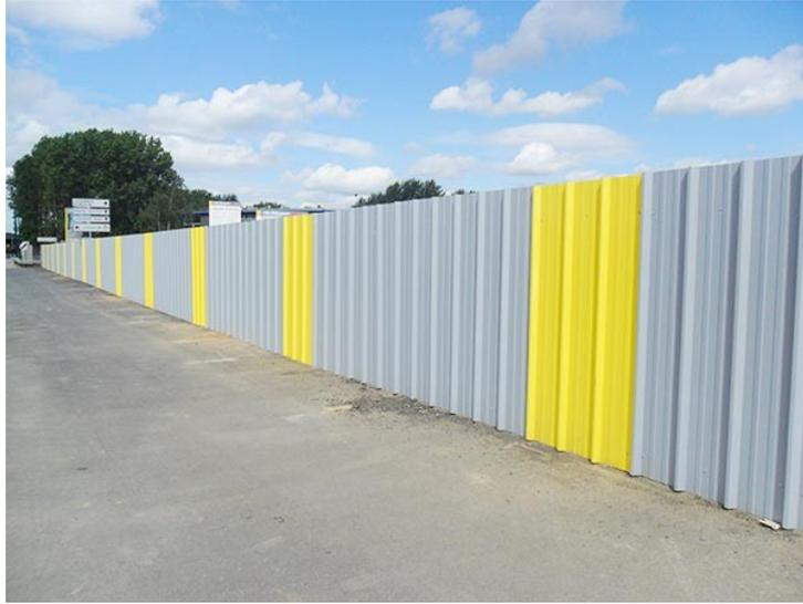
**Figure 74 : Exemple de clôture bardée**
