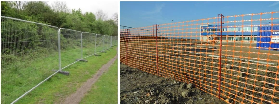
**Figure 75 : Exemple de grillage de chantier (à gauche) et filet de chantier (à droite)**
