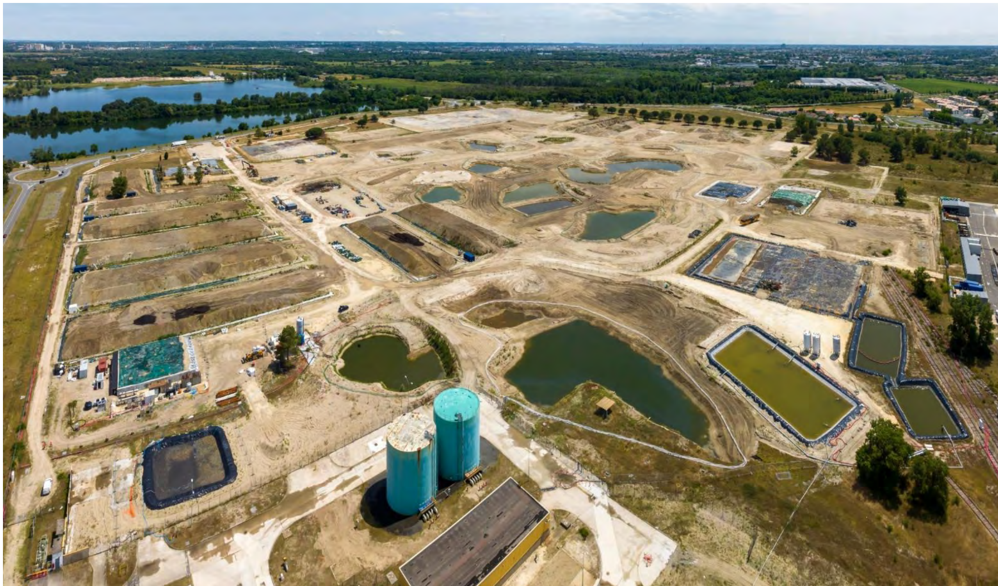
Photo 1 : Image drone de l'aire d'étude immédiate en 2023 - travaux de dépollution des sols en cours
