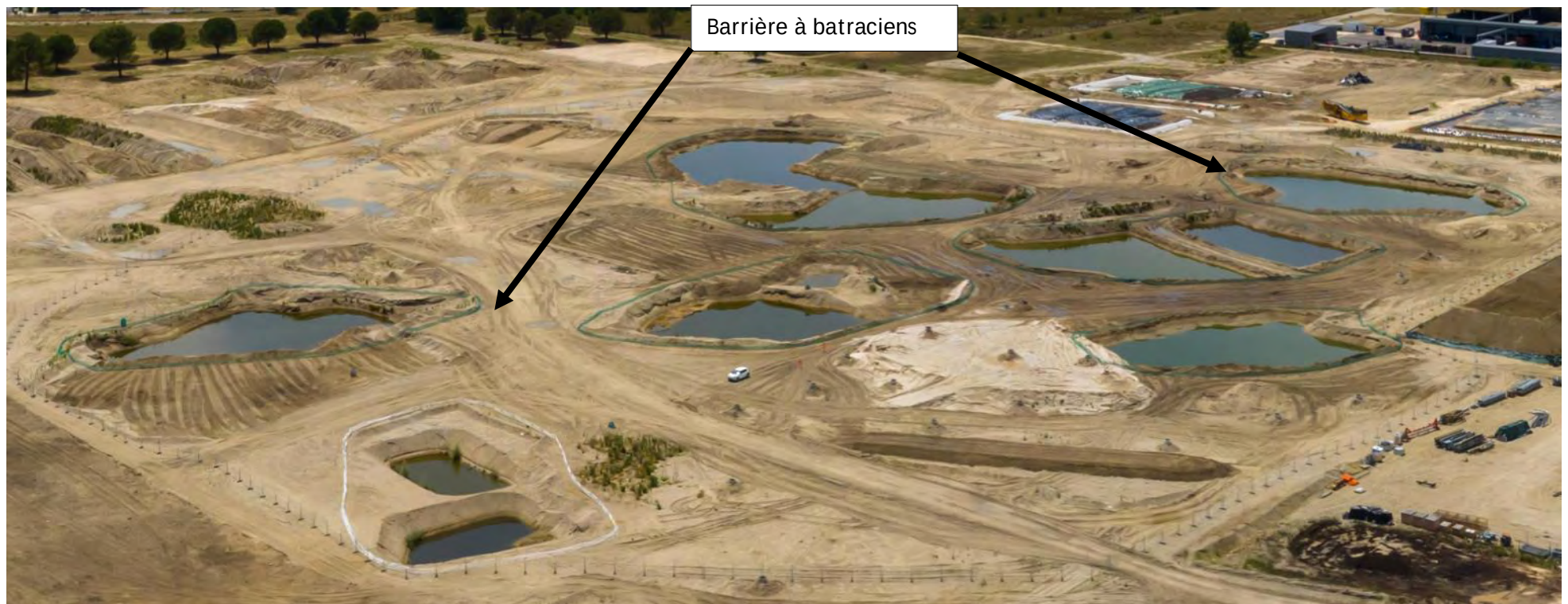
Photo 12 : Photographie aérienne illustrant la pose systématique d'une barrière à batraciens autour de chaque trou d'eau ponctuel sur le chantier de l'AEI
