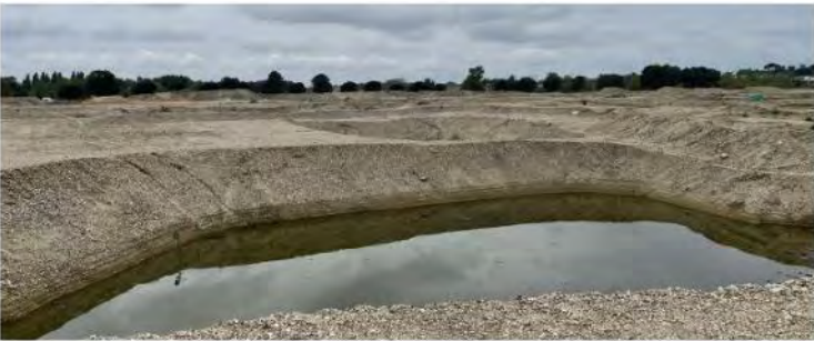
Aperçu de la zone de projet constituée par différents bassins creusés dans le cadre des opérations de dépollution de l'ancien site industriel de l'usine Ford
