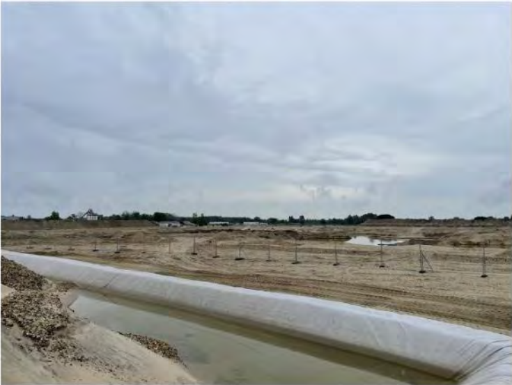
Vue sur l'ancien site industriel en cours de dépollution en avril 2023
