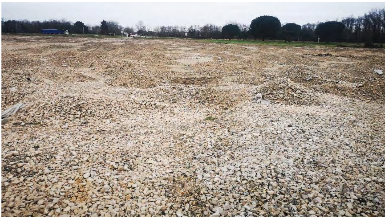
Photo 11 : Photographie du secteur de l'AEI en chantier = attractivité très faible pour l'avifaune en hiver
