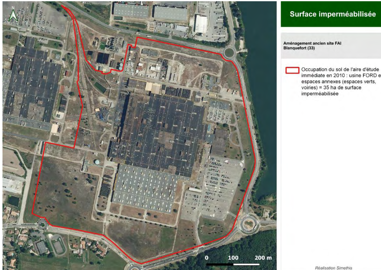
Carte 13 : Vue satellite de l'occupation du sol de l'aire d'étude immédiate par l'usine FORD (avant le présent projet d'aménagement AX TOM°)
