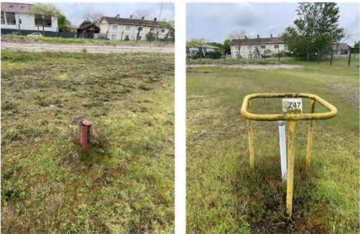
Aperçu de deux piézomètres présents au sud de la zone d'étude
