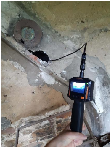
Figure 24 : Vérification des cavités à l'endoscope © EODD, 2021
