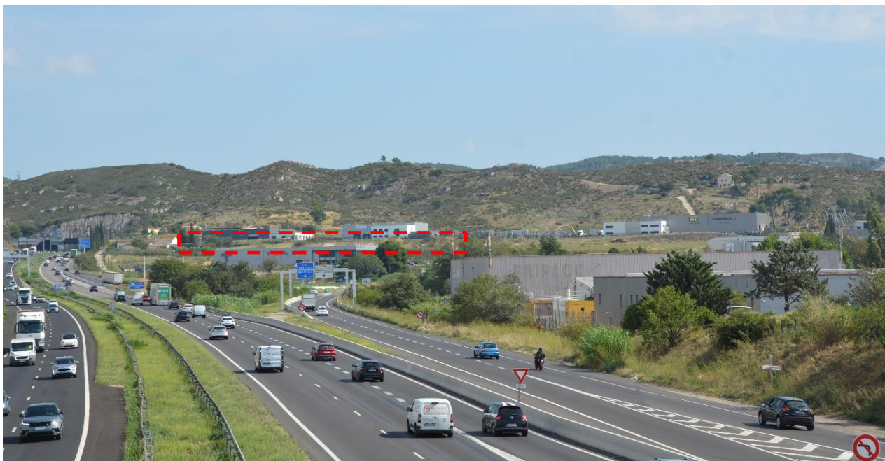
Vue 1 – Depuis la bretelle d'accès à l'Autoroute du Soleil A7
