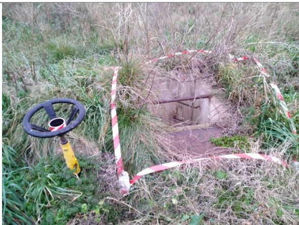
Ancien ouvrage d'irrigation.
