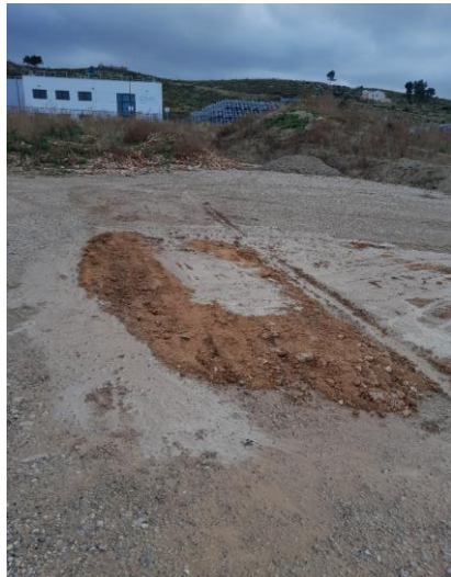
Fosse rebouchée après l'intervention
