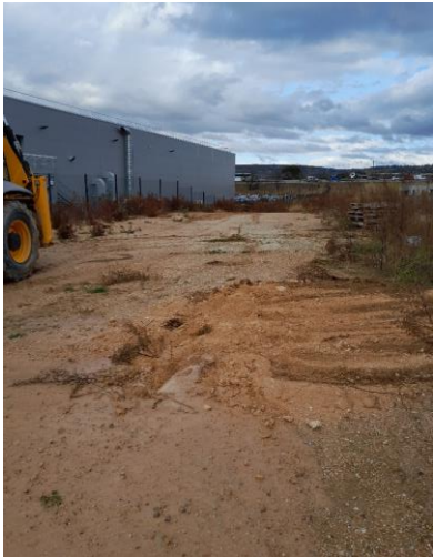
Fosse rebouchée après l'intervention
