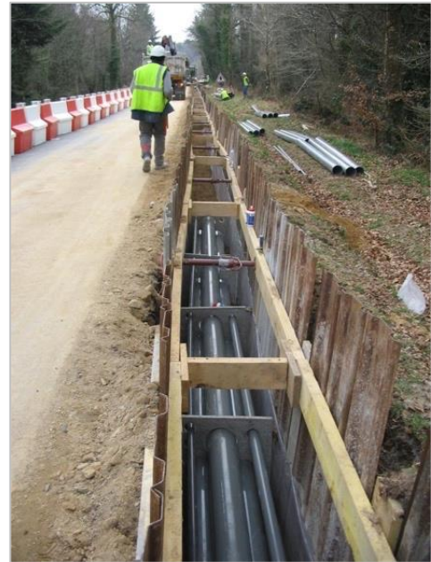
Coupe type d'une liaison souterraine en technique 225 000 volts (pose en trèfle)
