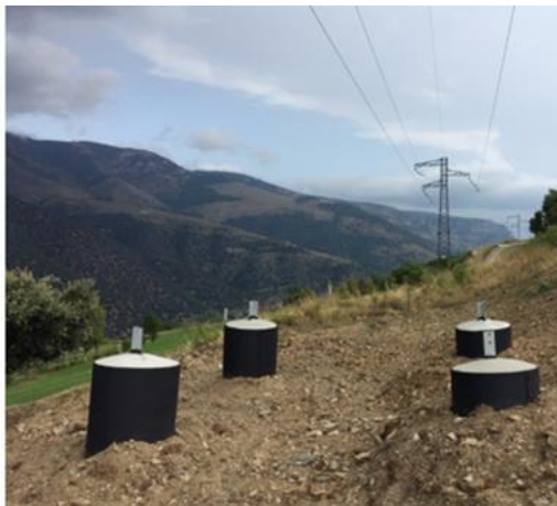
Exemple de fondation de pylône
