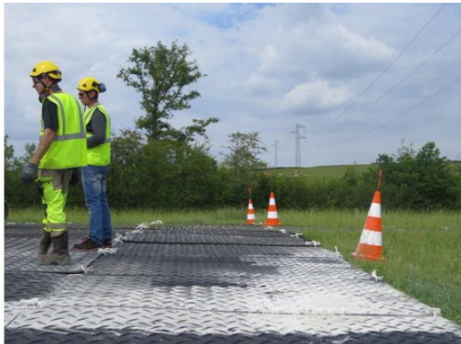
Exemple d'accès provisoire sur plaques en caoutchouc
