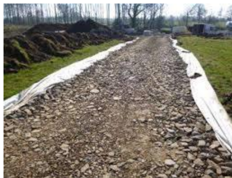
Exemple de piste provisoire sur géotextile
