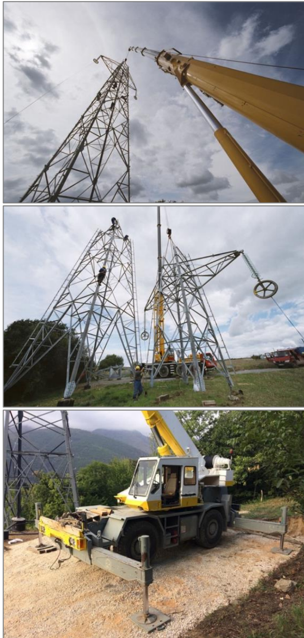
· Photos illustrant les opérations de levage d'un support
