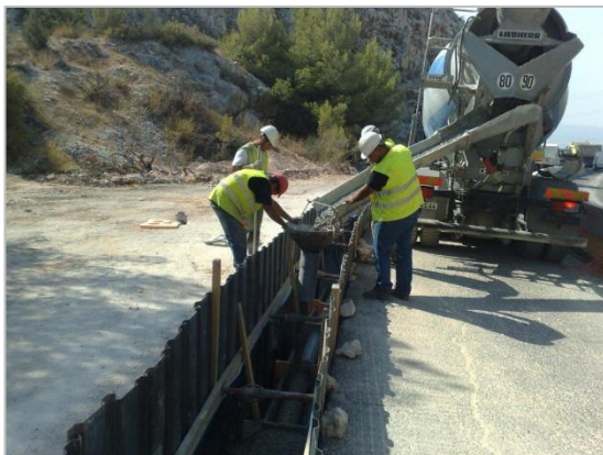
Coulage du béton.
