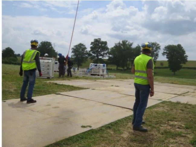
Exemple d'accès provisoire sur plaques en bois
