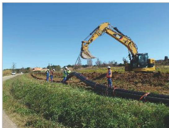
Pose des fourreaux PEHD en pleine terre.
