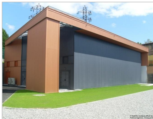
Exemple de bâtiment « PSEM »
