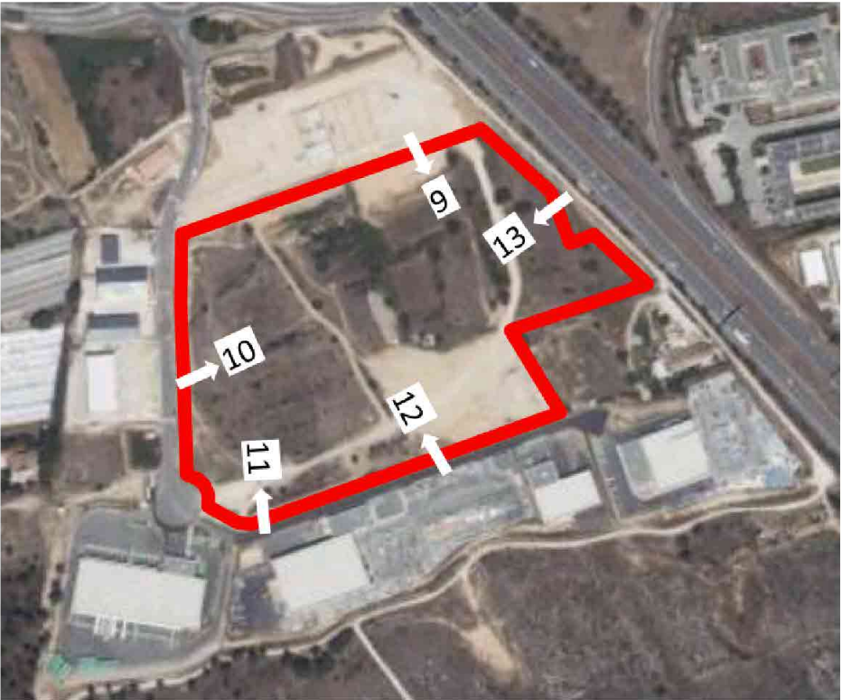
Repérage des photographies autour de la parcelle
