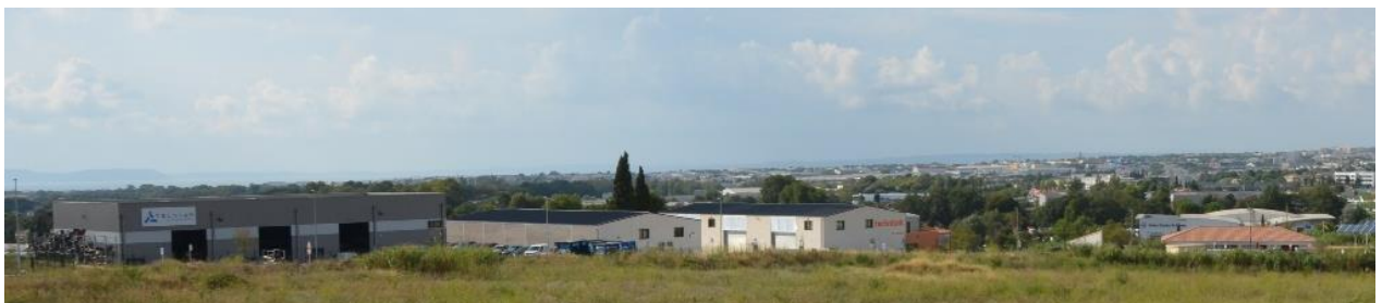
Vue 5 – Les sociétés Technitoit Marseille et Telstar, les restaurants les Halles des Sybilles et Chez Rémi
