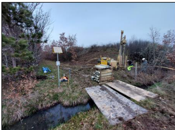
Vues de la foration du Pz2 (à gauche) et du Pz3 (à droite) (photographies Antea Group du 11/01/2024)
