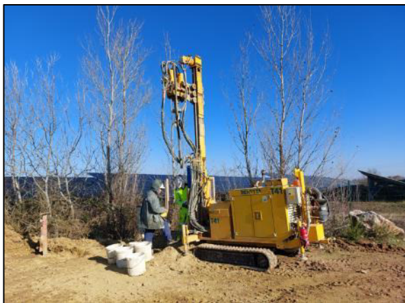
Vues de la foration (à gauche) et de l'équipement (à droite) d'un piézomètre (photographies Antea Group du 09/01/2024)
