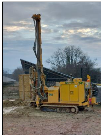
Vues de la foration du Pz4, Pz5 et Pz6 (de gauche à droite) (photographies Antea Group du 10 et 12/01/2024)
