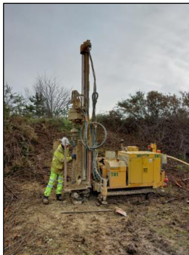
Vues de la foration du Pz2 (à gauche) et du Pz3 (à droite) (photographies Antea Group du 11/01/2024)
