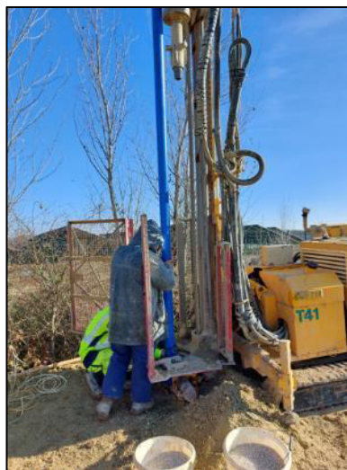
Vues de la foration (à gauche) et de l'équipement (à droite) d'un piézomètre (photographies Antea Group du 09/01/2024)
