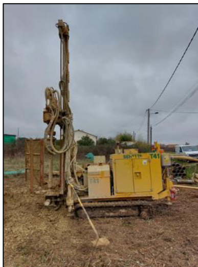
Vues de la foration du Pz4, Pz5 et Pz6 (de gauche à droite) (photographies Antea Group du 10 et 12/01/2024)
