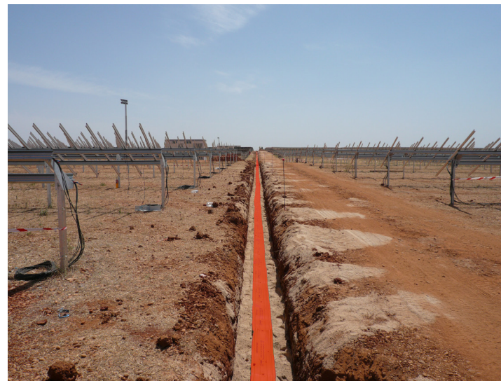
Pose des structures porteuses et raccordement interne
