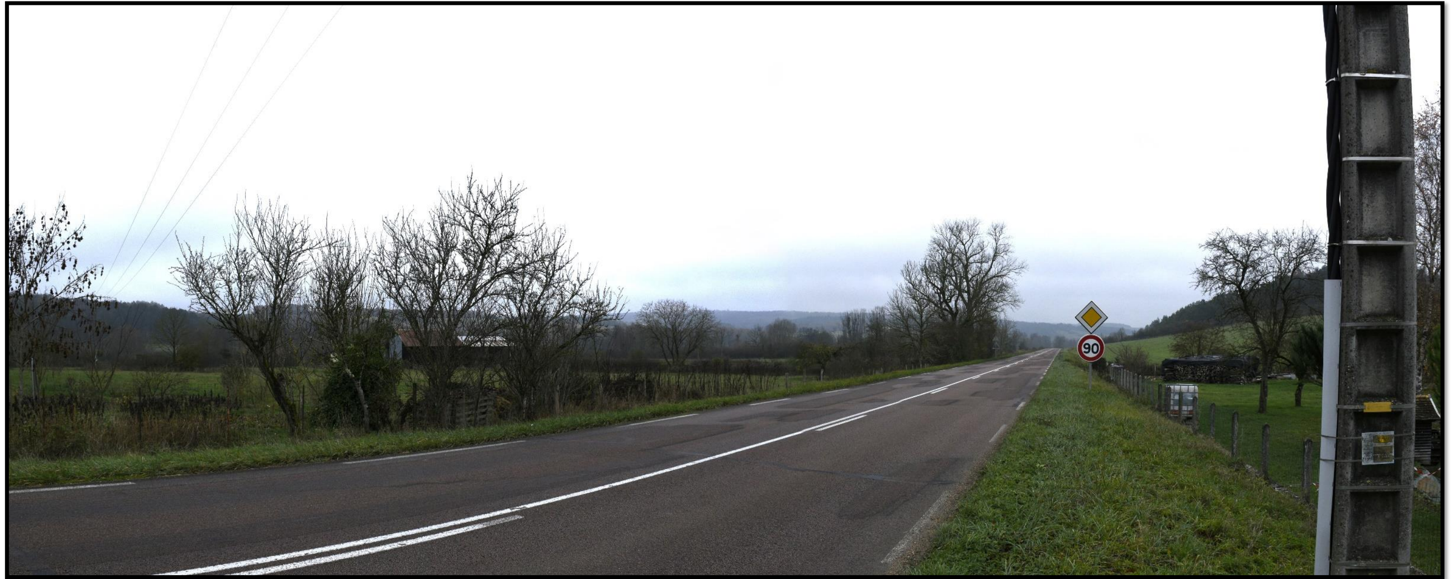
Figure 1-10 : Vue vers la zone de projet Ouest dite « Carrières » depuis la sortie Nord de Charrey-sur-Seine sur la D971
