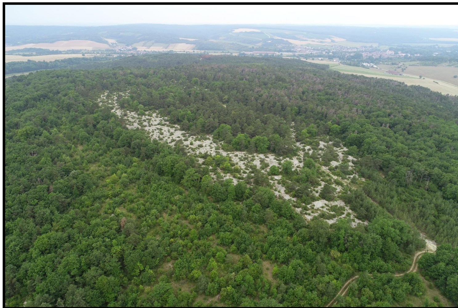
Figure 1-20 : Vue du site depuis l'Est avant la réalisation du projet
