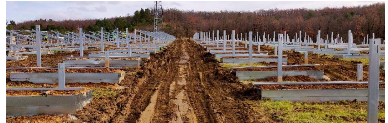
Figure n°4 : Exemple de structure utilisant des gabions (Société Ijes Solar)
