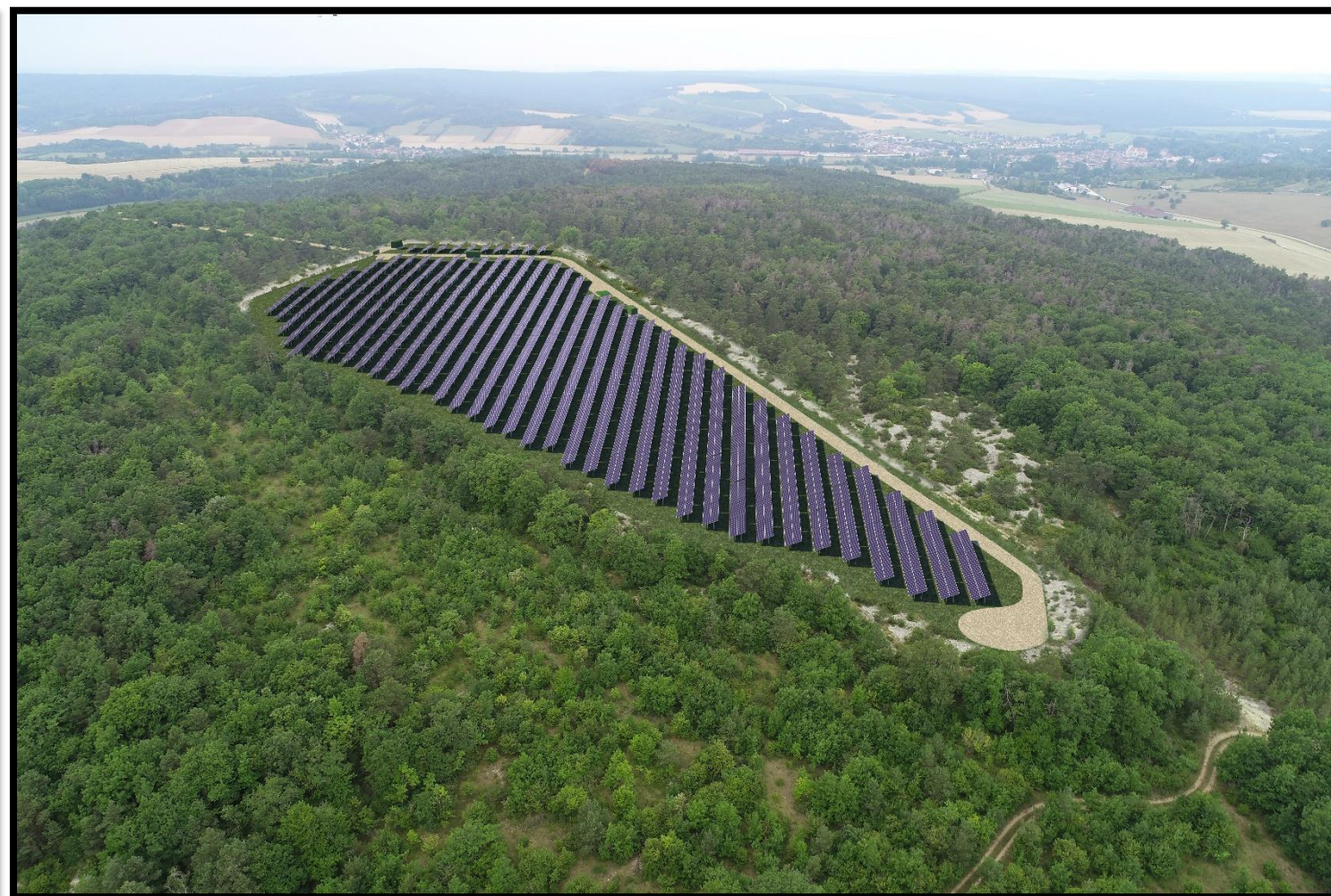
Figure 1-21 : Vue du site depuis l'Est après la réalisation du projet
