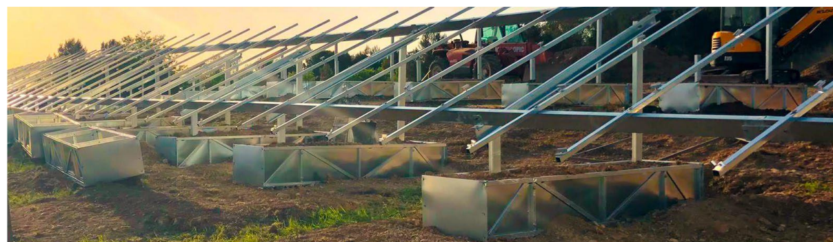
Figure n°3 : Exemple de structure utilisant des gabions (Société Ijes Solar)
