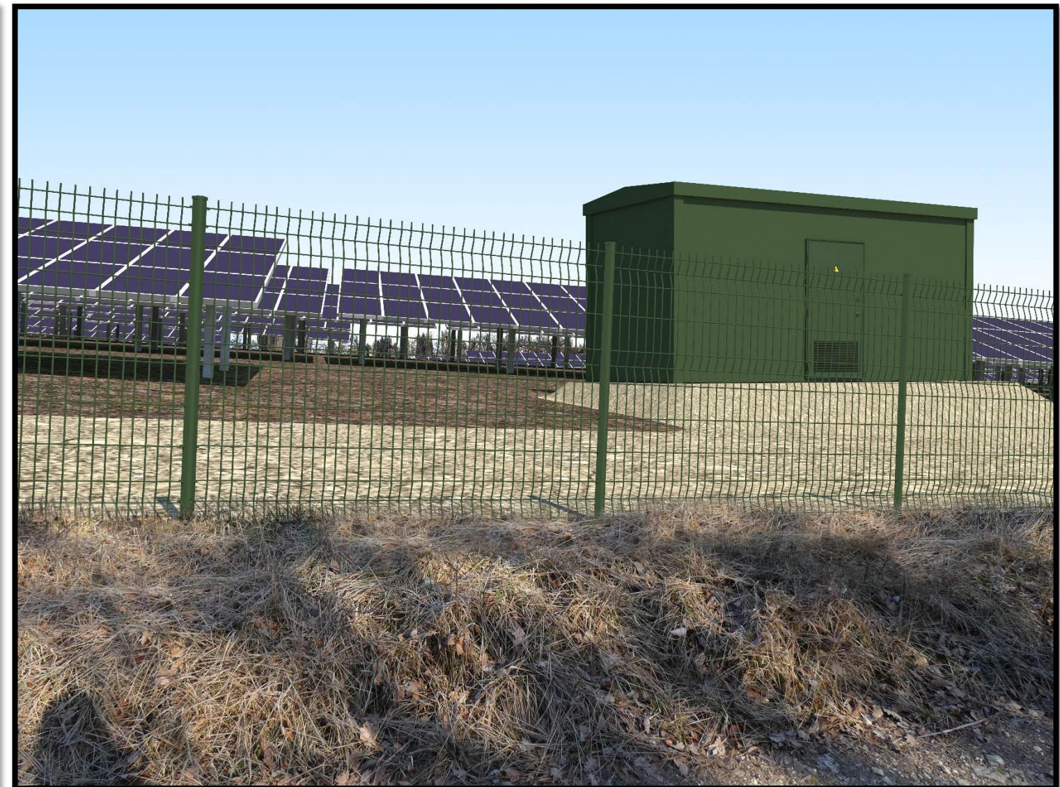
Figure 1-19 : Vue du site depuis le chemin rural au sud après la réalisation du projet
