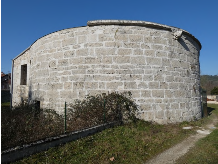
Figure 3-61 : Tour du Boulevard à Mussy-sur-Seine
