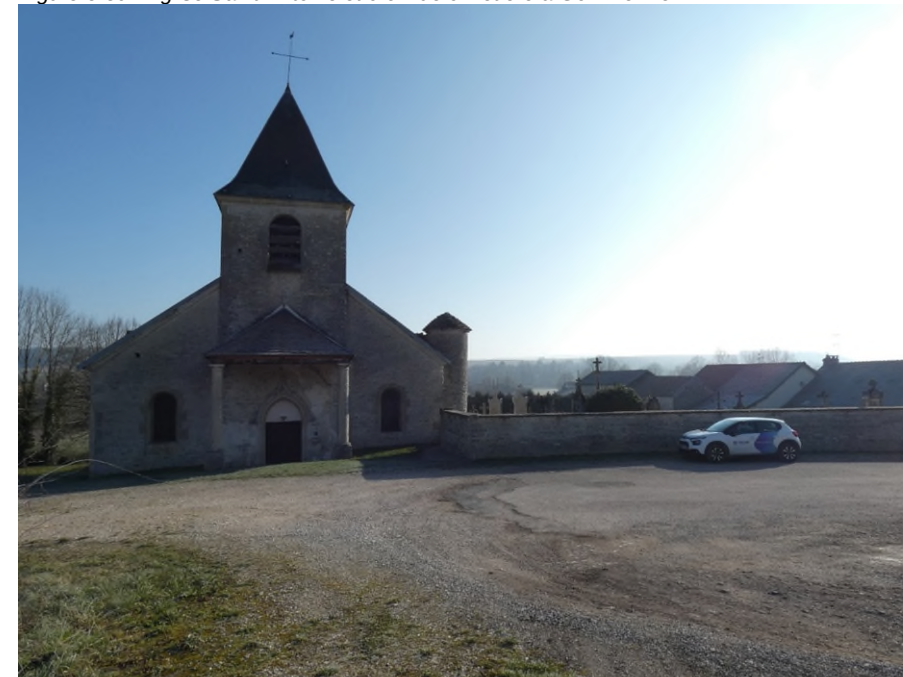
Figure 3-59 : Eglise Saint-Antoine et croix de cimetière à Gomméville
