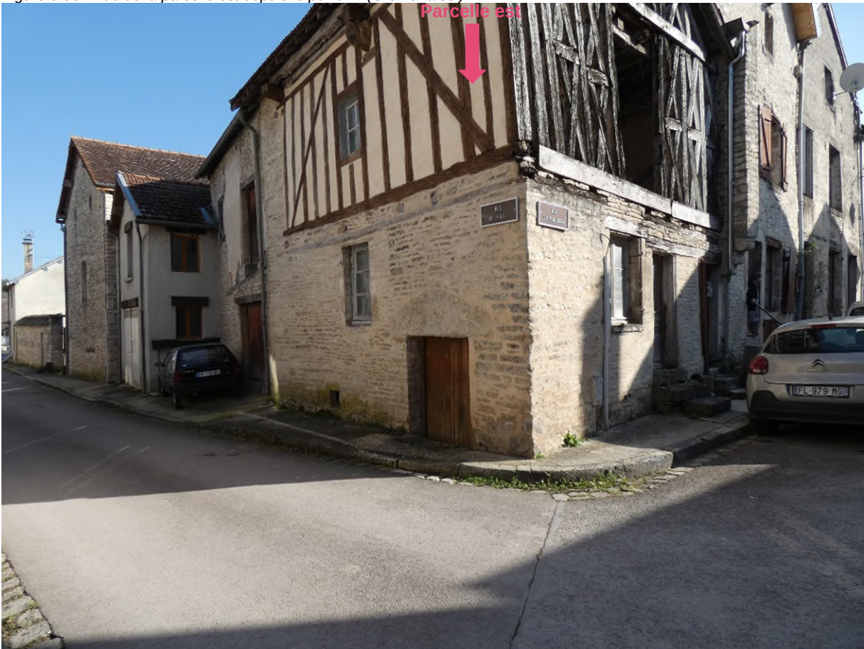
Figure 3-95 : Vue de la parcelle est depuis le point 11 (Grenier à sel)
