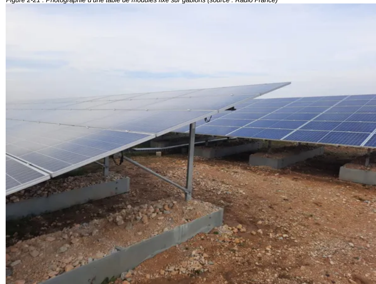
Figure 2-21 : Photographie d'une table de modules fixe sur gabions (source : Radio France)
