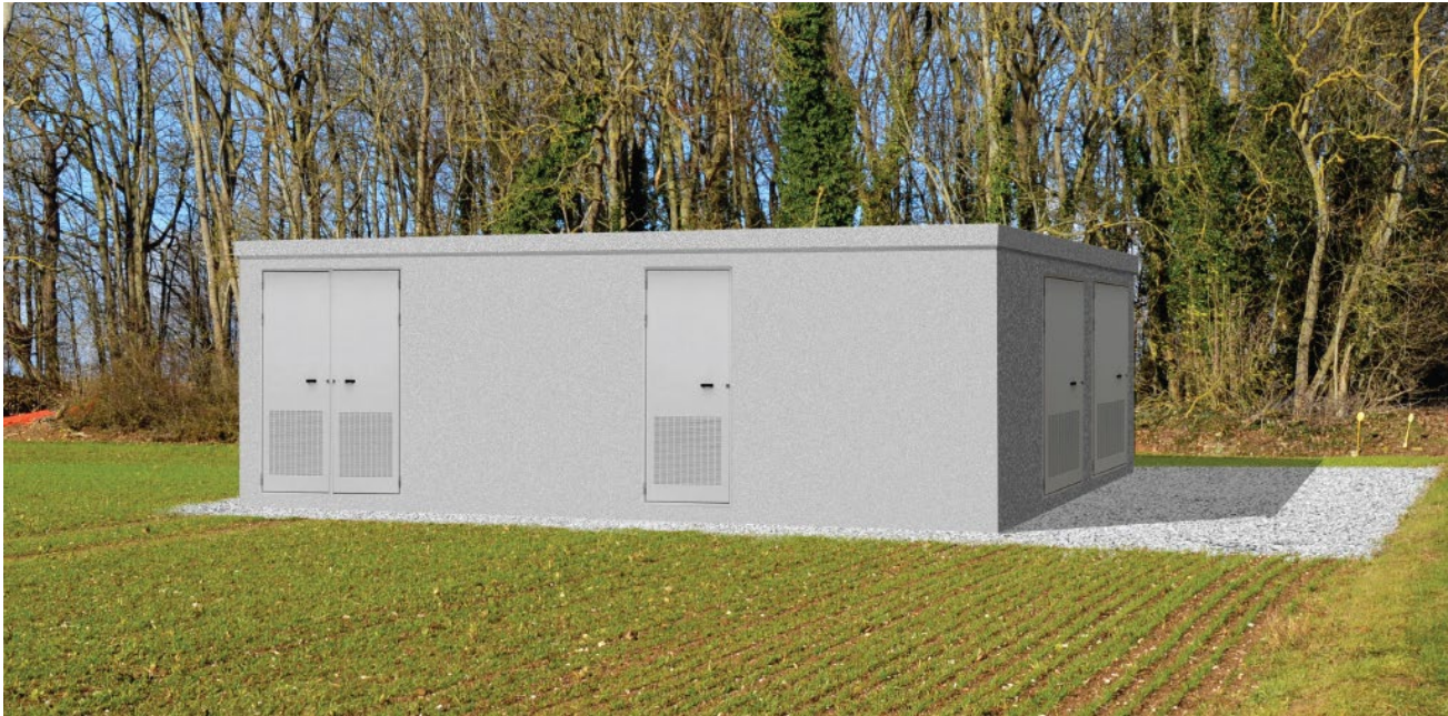
Illustration 13 : Illustration du poste de livraison électrique
