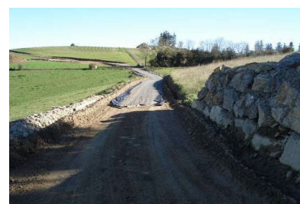
Illustration 22 : Mise en place du gravier
