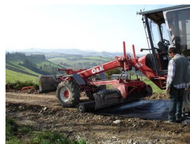
Illustration 21 : Pose du géotextile
