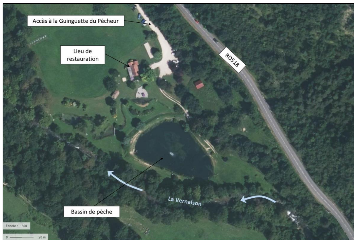
Vue aérienne de la Guinguette du Pêcheur (Source : Géoportail)
