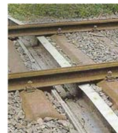
Figure 60 : Demi-buse posée sous la voie ferrée
