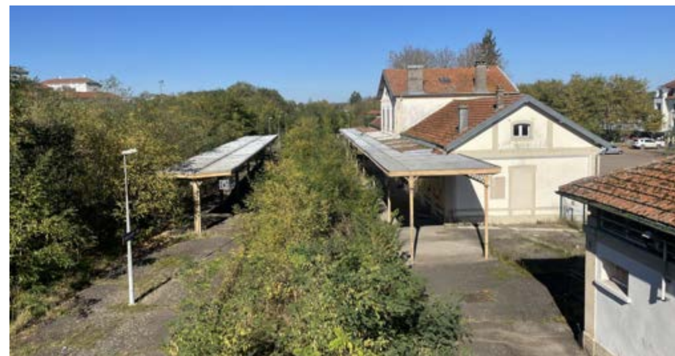
Figure 51 : Photo montrant la gare de Mirecourt, la végétation envahissant la voie et le site SMR à gauche. SMI. Source : Setec
