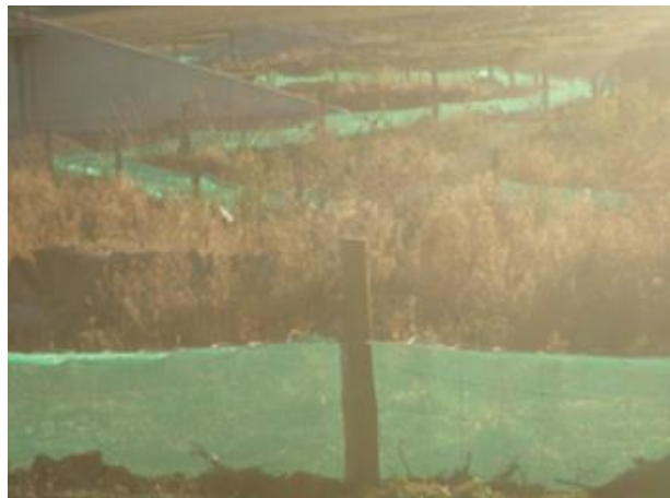
Figure 18 : Barrière provisoire avec bavolet (Source : Cerema)
