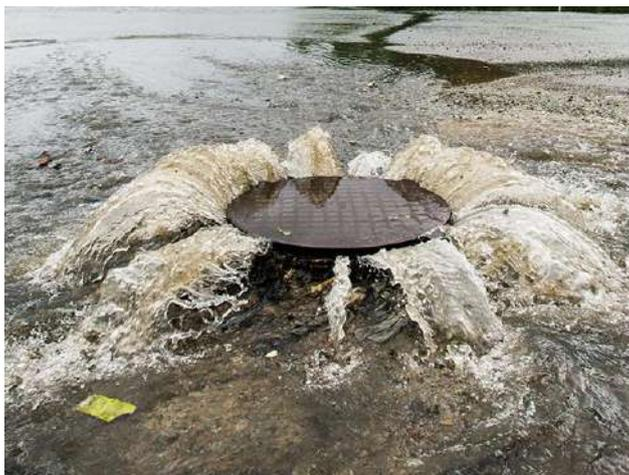
**Figure 11 : Illustration du phénomène d'inondation par refoulement de réseau pluvial**
