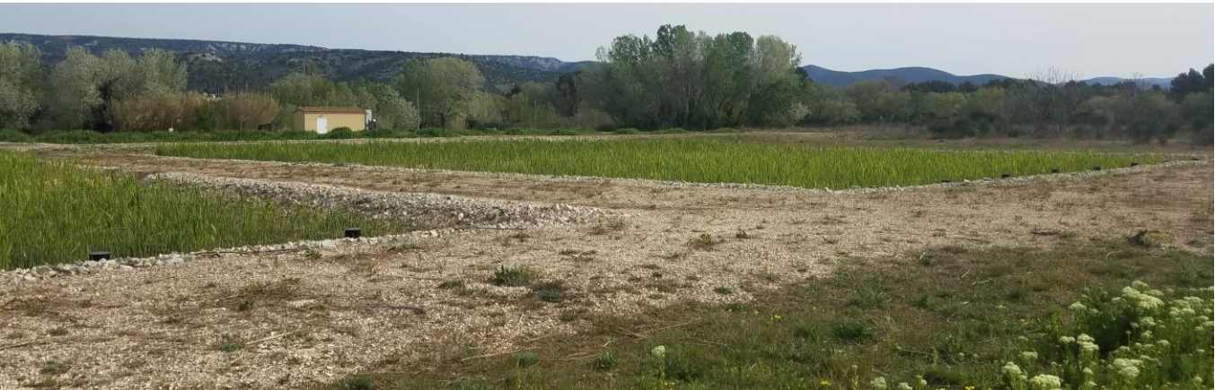
Photo 6. Bassin de la STEP dans le secteur d'étude Source : Auddicé
