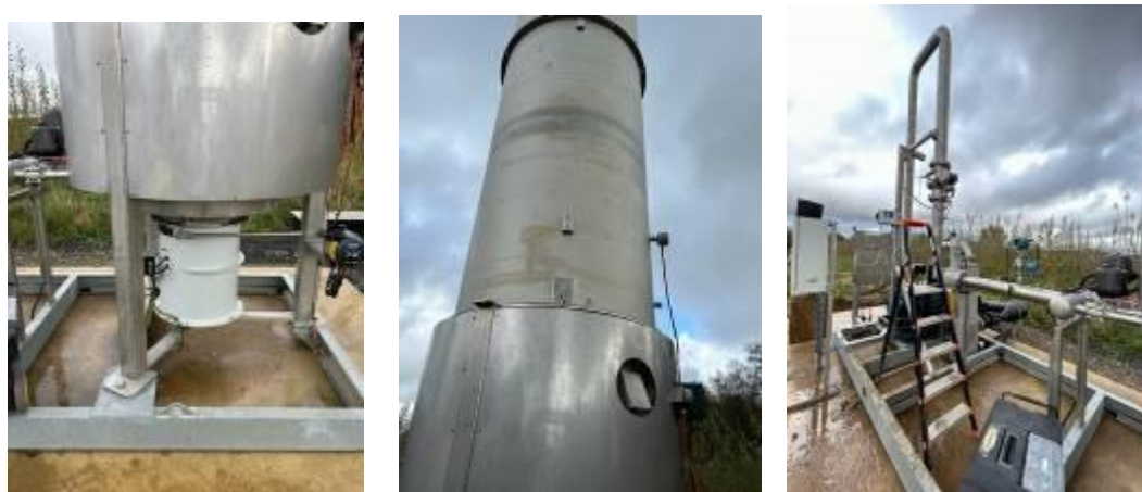
Figure 6 : nouvelle torchère avec instrumentation en cours de modification
