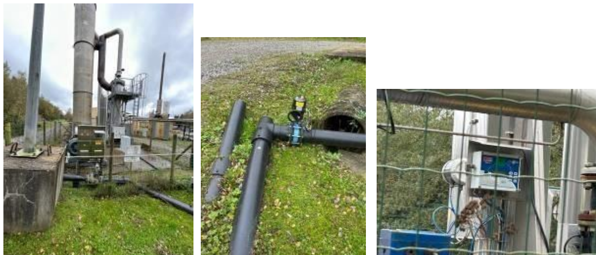
Figure 5 : Biochaude dans enceinte fermée, avec électrovanne et diverses instrumentations certifiées ATEX
