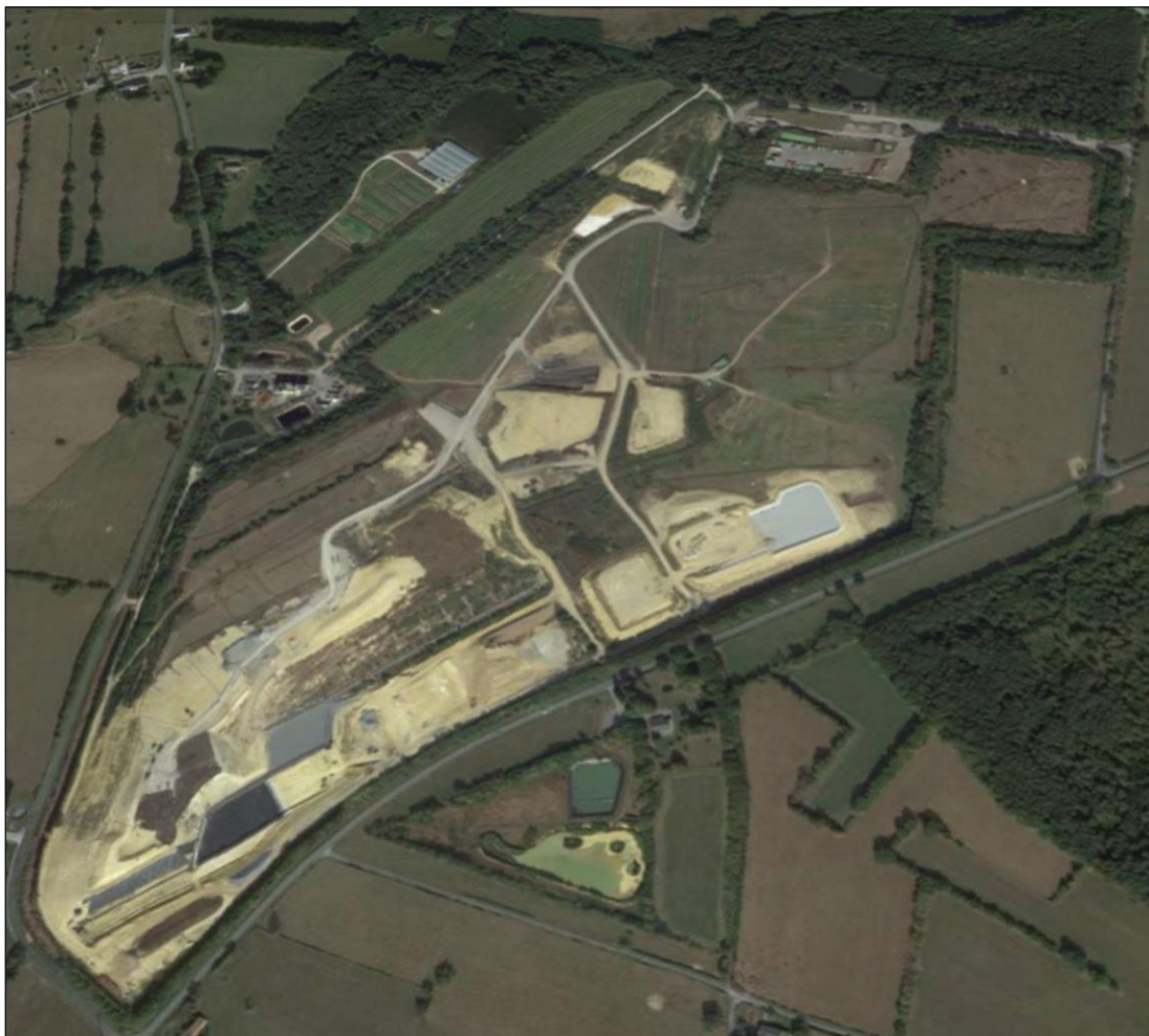
Vue satellite du site (Google Earth)
