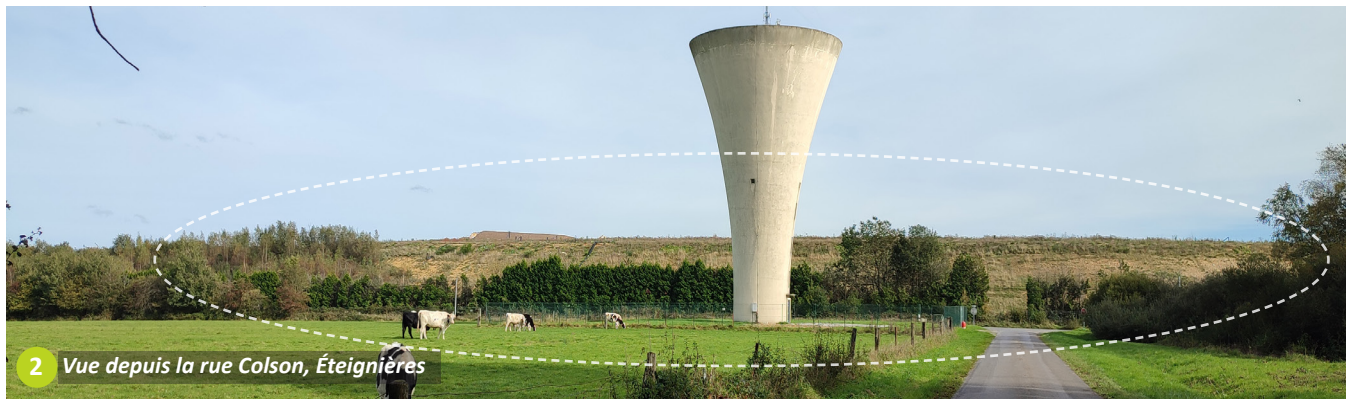
1 Vue depuis la route de Gascogne, Éteignières
