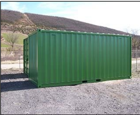
Exemple d'un local de maintenance
